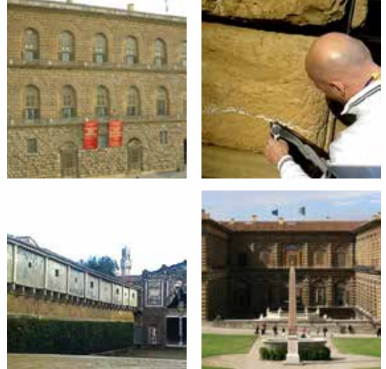
Palais Pitti (1440) - Intervention préliminaire à la consolidation.
