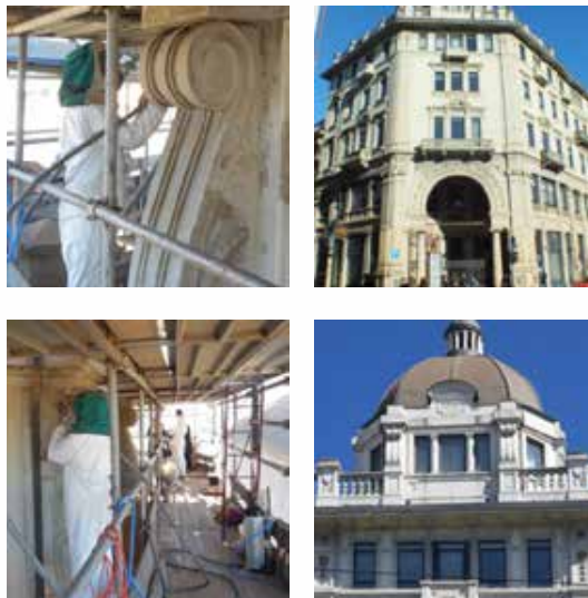
Ex Cinema Corso (1929) - enlèvement des couches de peinture avec almandin et coquilles de noix.
