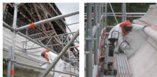
Tour Eiffel (XIX es s.ap. J.C.) - Nettoyage pylônes en pierre.
