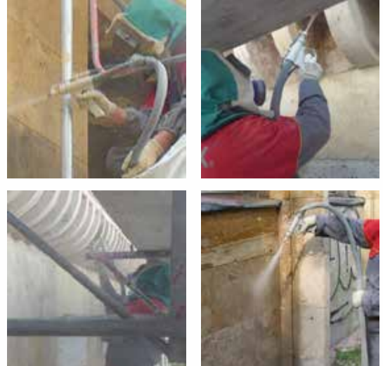
Postpalais - Nettoyage de patine de smog avec almandin et vaporisation d'eau.
