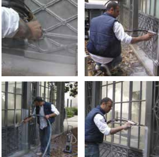
Structures en aluminium: nettoyage du smog avec bicarbonate de sodium.
