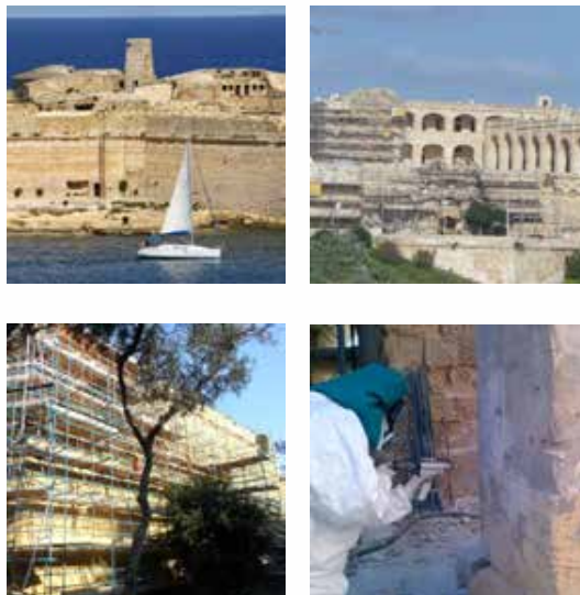
Fortifications du XVIème siècle - Nettoyage de la délicate pierre maltaise avec carbonate de calcium.
