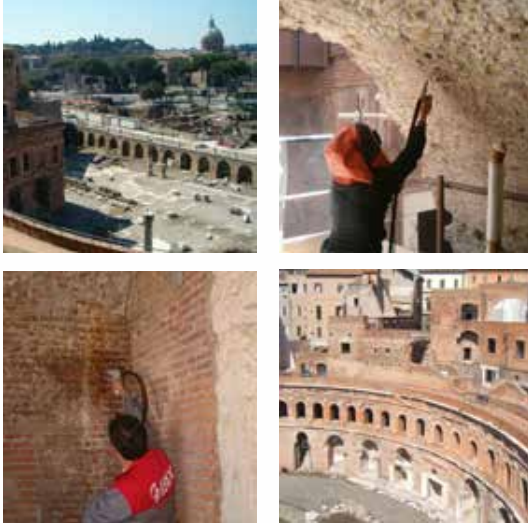
Forums Impériaux Musée de Trajan (1er s. ap. J.C.) - Nettoyage pierres tufières et moellons, briques tufières et mortier, travertin.
