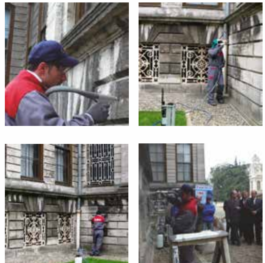
Dolmabahçe Palace - Nettoyage de la pierre Kufeki, à sec et avec de l'eau micronisée et du carbonate de calcium.
