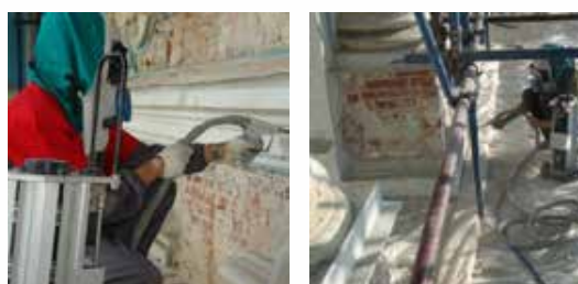
Palais Catherine (1717) - nettoyage de la façade des dépôts tenaces avec almandin.
